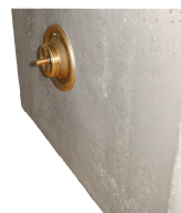
Bonde à 19.5cm du mur, centrée dans le bac (21cm)
